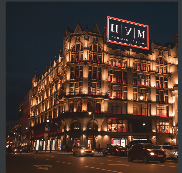
Локальное освещение фасада
